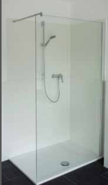
offen begehbare Dusche
